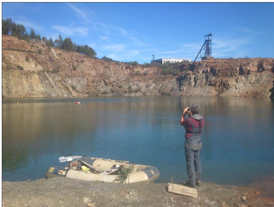
Figura 41. Aspecto de los dos dispositivos de desgasificación instalados en la zona central del lago de la corta Guadiana en Abril de 2014 (segundo plano) y en Octubre de 2014 (primer término).
