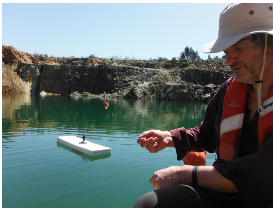
Figura 40. Maniobras de preparación e instalación del primer dispositivo de desgasificación en el lago de la corta Guadiana (Abril de 2014).
